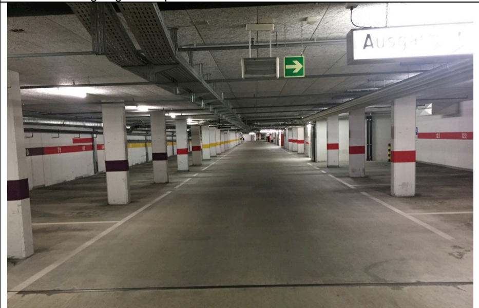
Öffentliche Tiefgarage Haus am Marktplatz
