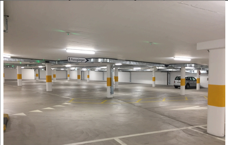
Öffentliche Tiefgarage Wohnpark Promenade
